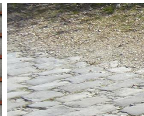
Revêtements de sol
