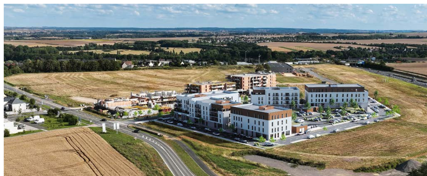
Travaux en cours
